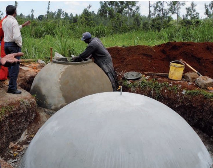
Bau einer Biogasanlage in Kenia
