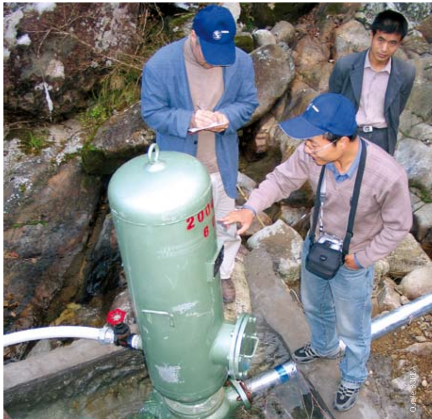
China: Neu installierter hydraulischer Widder
