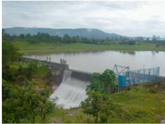
Der kleine Damm des Kraftwerks
