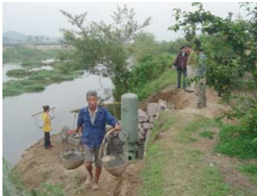
Installation eines hydraulischen Widders
