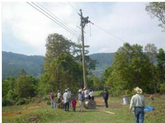
Verlegung der Stromversorgung für ein Dorf
