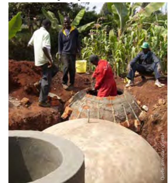
Kenia: Bau einer Biogasanlage
