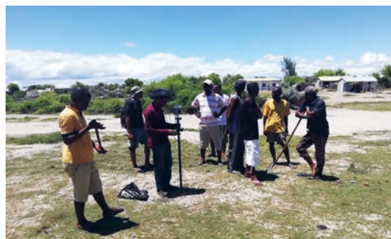
Ingenieure führen Messungen durch, um die Erdarbeiten in Mangily vorzubereiten
