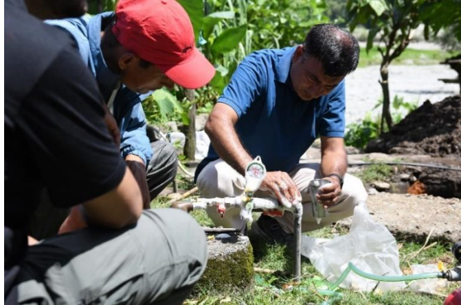
Abbildung 1: NBPA-Techniker überprüfen Gasleitungen und tauschen schadhafte Teile aus
