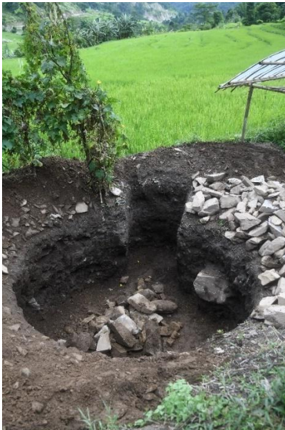
Abbildung 3: Tiefbauarbeiten für neue Anlage
