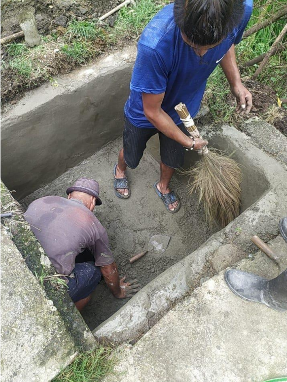
Abbildung 11: NBPA-Mitarbeiter erneuern alte Biogasanlage
